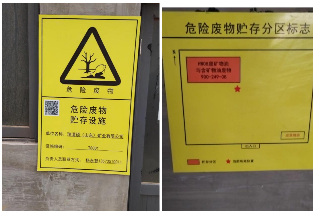
危废暂存间标识及分区标志
